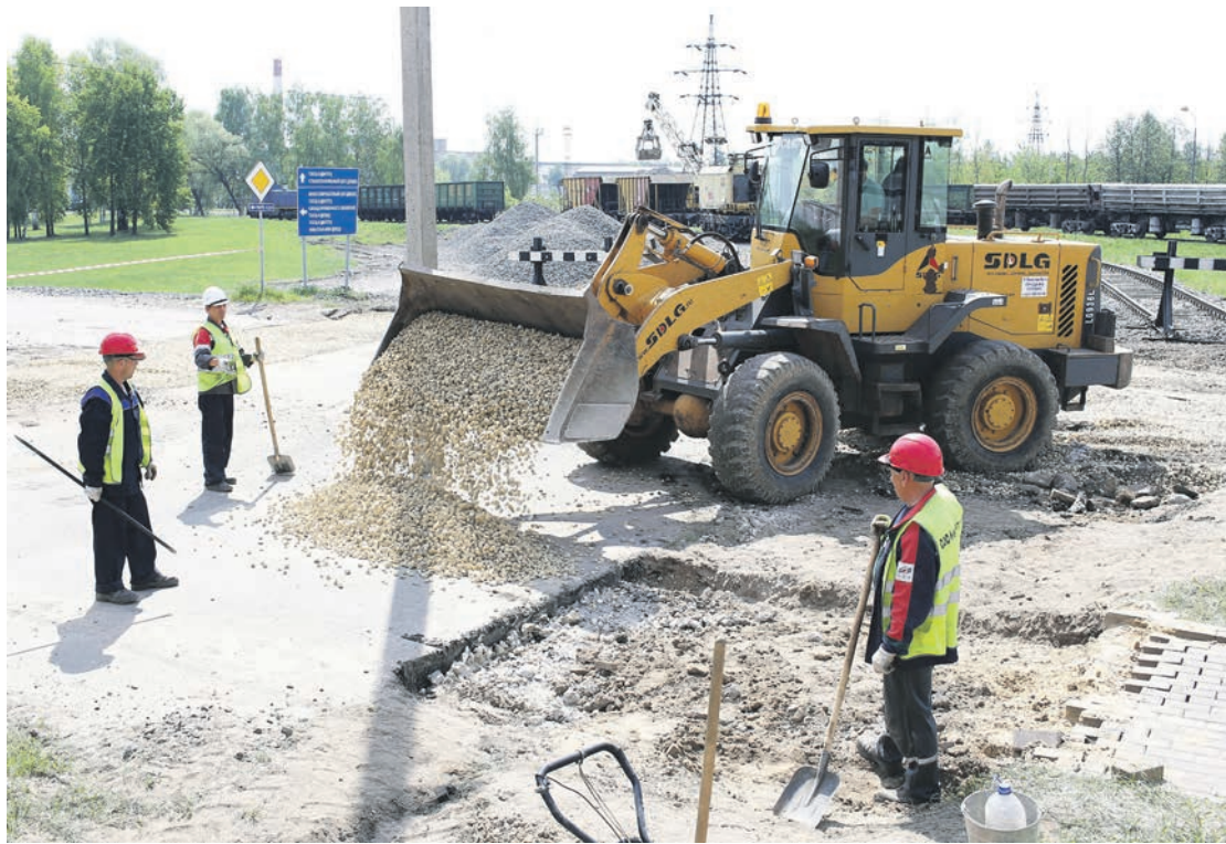
△ На территории ВМЗ ремонт дорог начался уже весной © ВАЛЕРИЙ ПОКУМЕЙКО
